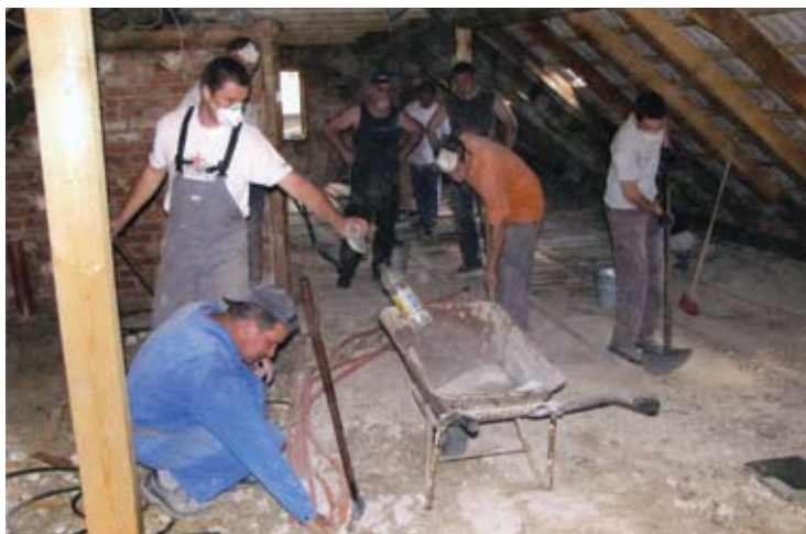
Priprava na betonsko ploščo na podstrešju doma 2008
